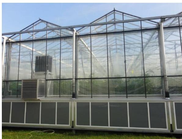
Abbildung 17 Ansicht aussen AVS (Quelle: Ammerlaan Constructions)
