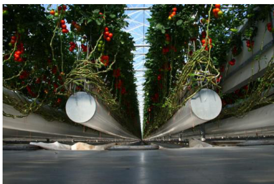
Abbildung 14 Luftschlauch unter Rinnen (Quelle: Ammerlaan Construction)
