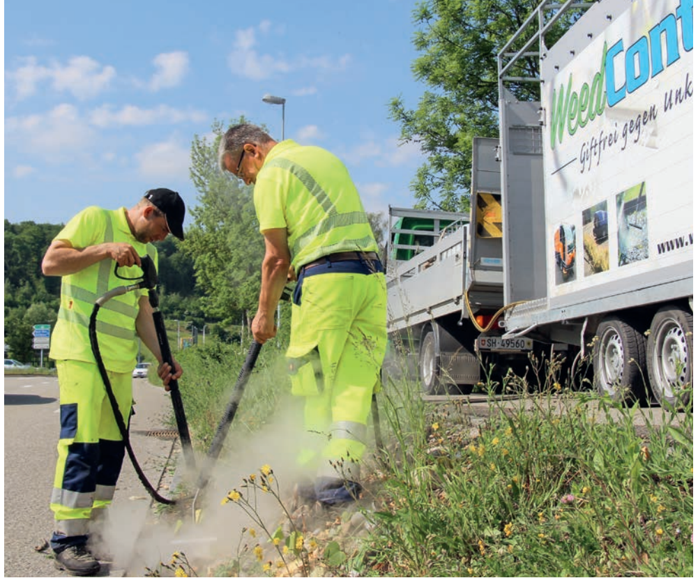
Links: Heissluft- und Abflammergeräte sollen langsam über eine Fläche gefahren werden. Foto: InfraWeeder
