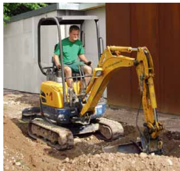
Hochwertige Baumaschinen erfordern Fachleute, die eine sichere Bedienung gewährleisten.
