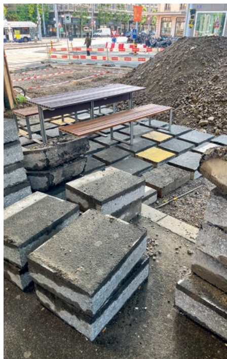
Chantier à Rive. Fig. 18 (à g.): Dallage recyclé en cours. Pose des dalles d'enrobé bitumineux recyclé, stock de grave alluvionnaire extraite sur site pour la reconstitution des sols destinés à être perméables et végétalisés. Fig. 19: Dallage recyclé installé. Quelques mois après la fin des travaux, le revêtement est praticable, la végétation est en cours d'installation, les assises sont accueillantes et le sentiment de fraîcheur bien présent. Fig. 20: Assise et sol pour pelouse rudérale. La valorisation des matériaux de site passe par le réemploi d'éléments comme le revêtement bitumineux pour la réalisation de dallage mais aussi de mobilier urbain, qui a défaut d'être très confortable permet une économie de ressources. photos: E. Amos/Jacquet SA (à d.)
