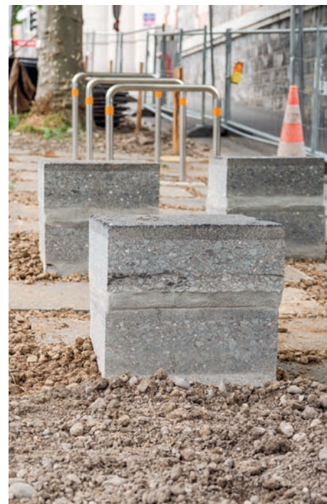
Chantier à Rive. Fig. 18 (à g.): Dallage recyclé en cours. Pose des dalles d'enrobé bitumineux recyclé, stock de grave alluvionnaire extraite sur site pour la reconstitution des sols destinés à être perméables et végétalisés. Fig. 19: Dallage recyclé installé. Quelques mois après la fin des travaux, le revêtement est praticable, la végétation est en cours d'installation, les assises sont accueillantes et le sentiment de fraîcheur bien présent. Fig. 20: Assise et sol pour pelouse rudérale. La valorisation des matériaux de site passe par le réemploi d'éléments comme le revêtement bitumineux pour la réalisation de dallage mais aussi de mobilier urbain, qui a défaut d'être très confortable permet une économie de ressources. photos: E. Amos/Jacquet SA (à d.)
