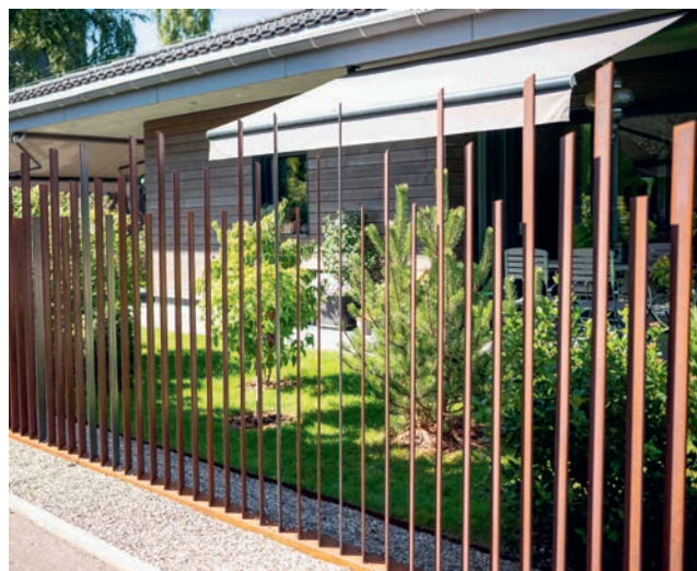
Fig. 10, 11: Lames brise-vue. Détail de scellement (croquis). Le principe du brise-vue est de filtrer le regard, maintenir une transparence tout en occultant les vues directes. S'utilise généralement par séquences ciblées sur des angles de vues stratégiques. photo: Schaller, croquis: E. Amos & B. Goyard
