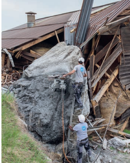
À g.: Un bloc d'une centaine de tonnes, débité sur place au fil diamanté pour une réutilisation locale comme l'étaient dans les temps passés les blocs erratiques* – seuls les moyens ont changés. Au centre: Extrait du carnet de débit établi conjointement avec le scieur selon les vœux de l'architecte paysagiste. À d.: La place et ses éléments de composition en roche de Nendaz. photos: en-dehors Sàrl
