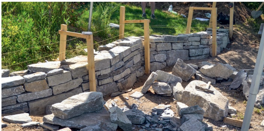
Cas de figure 3: Ci-dessus: Le banquetage, une étape importante pour la bonne exécution de l'ouvrage, rendue compliquée ici par la forme ondulante du mur. photo: 1001 Jardins
