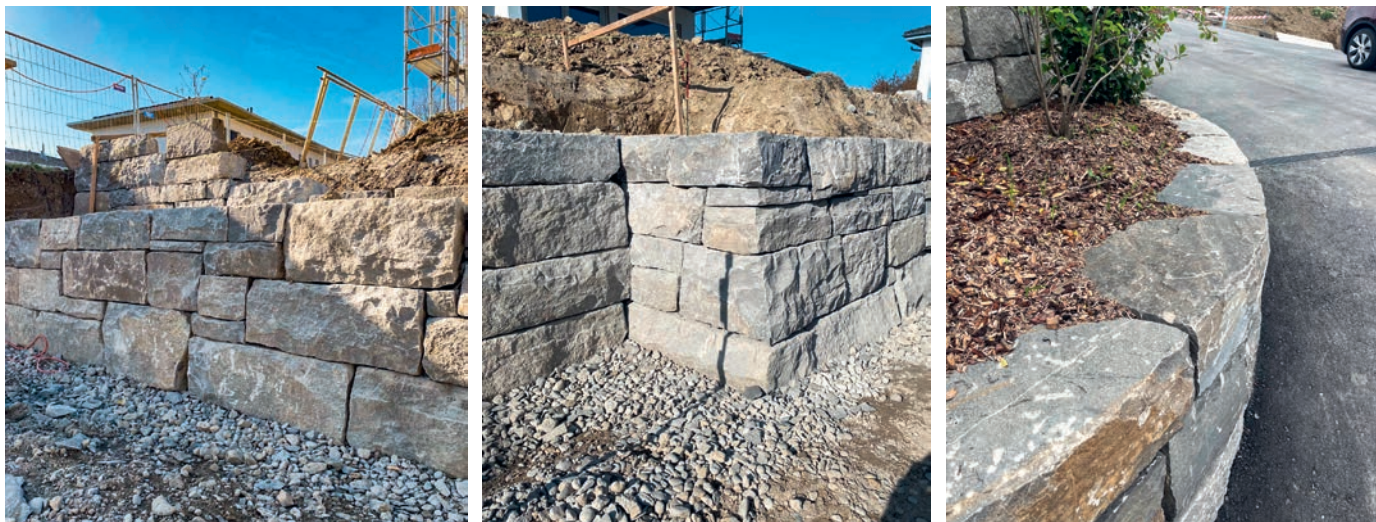
Cas de figure 1: Détails de construction selon les principes des murs de pierre sèche: fondation flottante, assises horizontales, joints ajustés, fruit du parement, façon d'angles et courbes soigneusement appareillés – une réalisation exemplaire. photos: E. Amos/1001 Jardins
