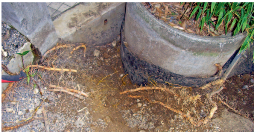
... Bambus ohne Bambussperre, der in diesem Fall bis in die Kanalisation hineingewachsen ist ...,
