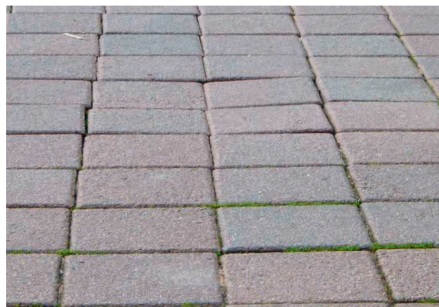
... oder zu grosse Lasten bei unfachgerecht verdichtetem Untergrund.
