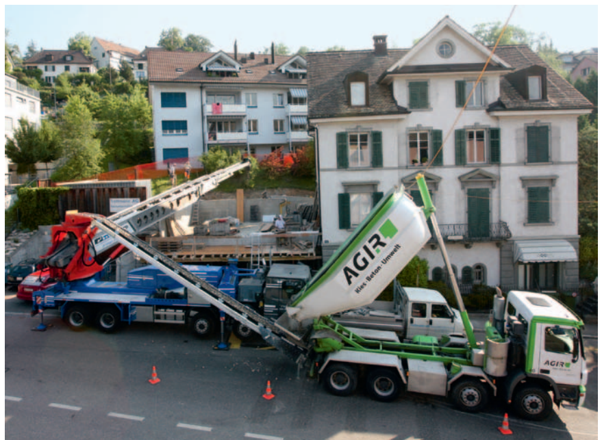
Bild rechts: Der Telebelt TB 110 bringt mit weit ausfahbarem und schwenkbarem Förderband Schüttgüter an schwer zu erreichende Stellen.
