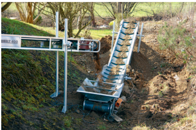
Bild links: Ohne den Untergrund zu zerwühlen, wird Aushub mit mehreren tragbaren Förderbändern über Höhendifferenzen transportiert.
