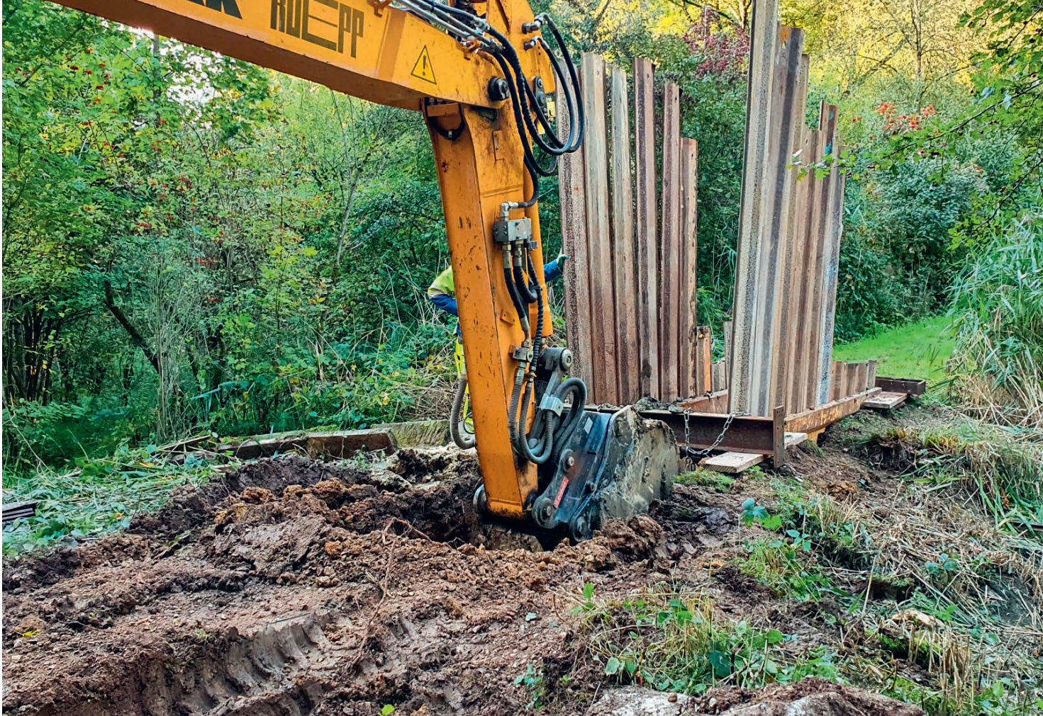
Um den leckgeschlagenen Teich abzudichten, wurde ein Graben ausgehoben. Die Wände wurden seitlich durch Schalungen gesichert (Foto rechts). Die Umweltverträglichkeit wurde durch den Kanton Schwyz bestätigt, wo das Verfahren 2015 auf einer Baustelle in Lachen eingesetzt und langzeitgeprüft wurde.
