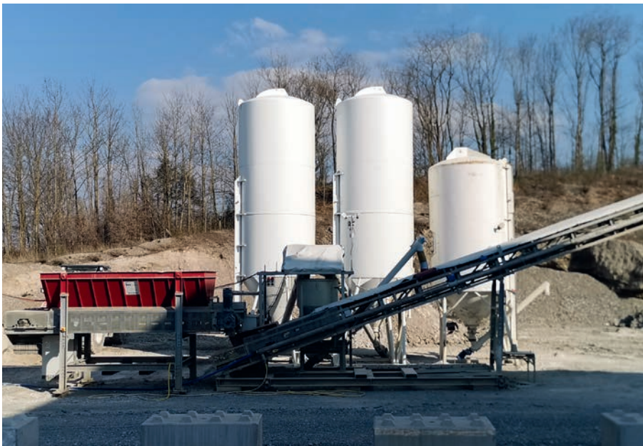
In der Mischanlage der RSS Flüssigbeton AG in Stein (AG) wird der Flüssigboden vorbereitet.
