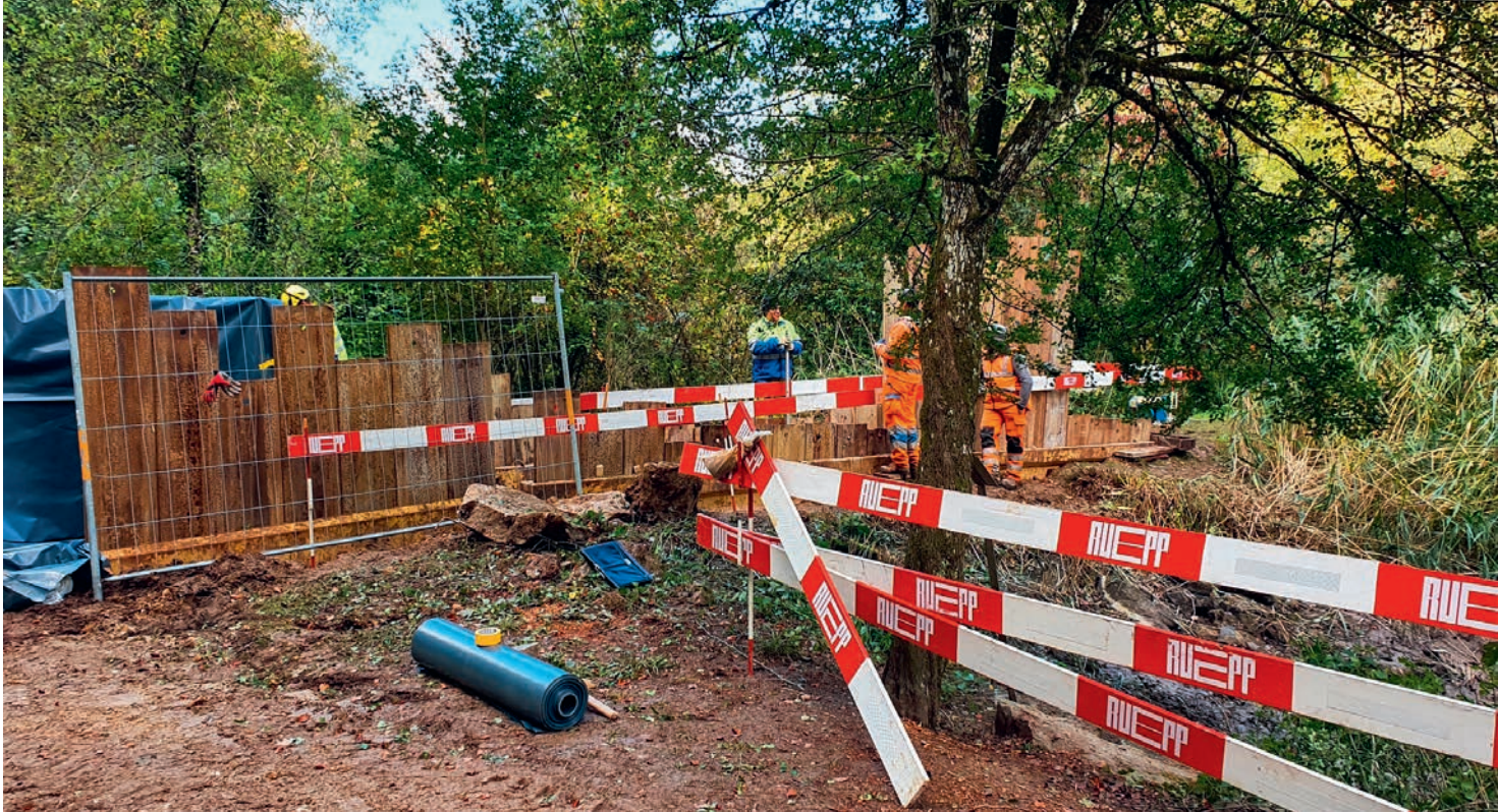
Nachdem auf der kompletten Länge ausgehoben wurde und die Grabenwände abgesichert sind, kann mit der Verfüllung der Schlitzwand begonnen werden.
